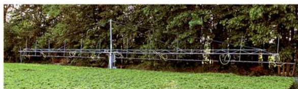
Venkovní mostové závlahy
