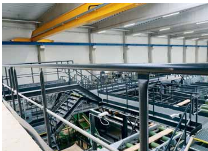
Pohled do pilnice.
