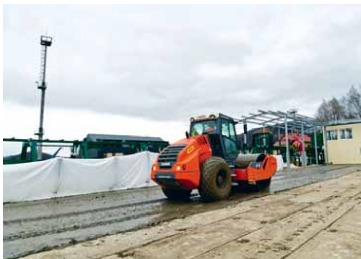
Budování zpevněných ploch před odkorňovací linkou.
